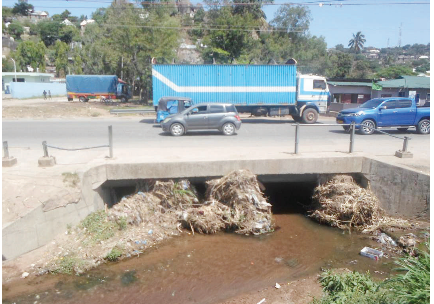
Mwonekano wa daraja la mto Mirongo lililopo Mabatini jijini Mwanza, ambalo chini limeziba taka zinazosababisha kuzuia maji kupita kirahisi nyakati za mvua. PICHA: ANTHONY GERVAS.
