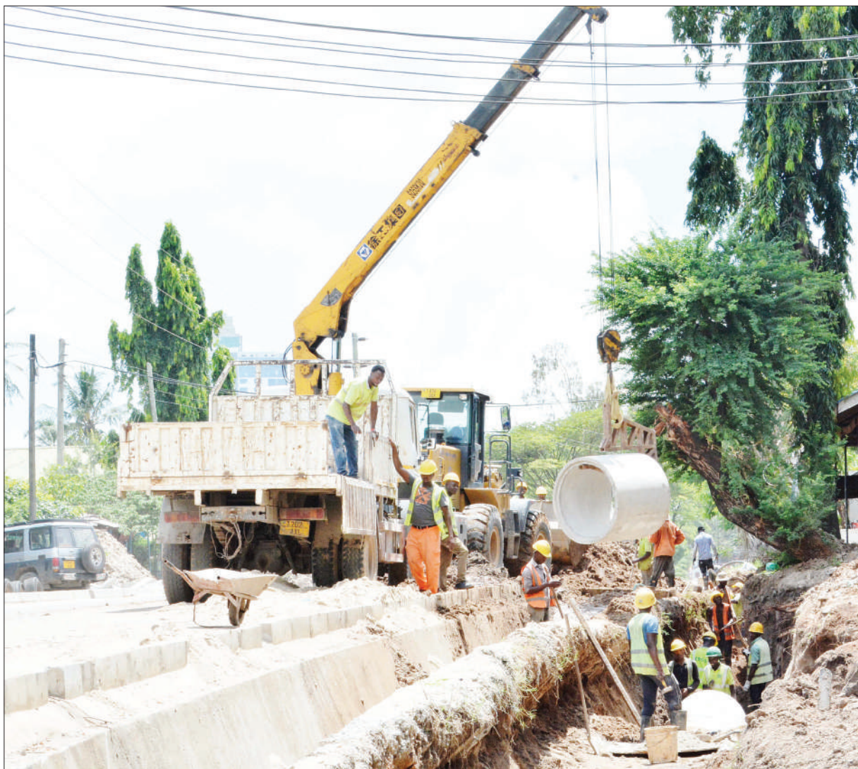
Mafundi wakiendelea na kazi ya ujenzi wa kuweka mabomba ya maji machafu katika eneo la Shule ya Sekondari Mama Salma Kikwete, eneo la Kijitonyama, jijini Dar es Salaam jana. Picha: MIRAJI MSALA
