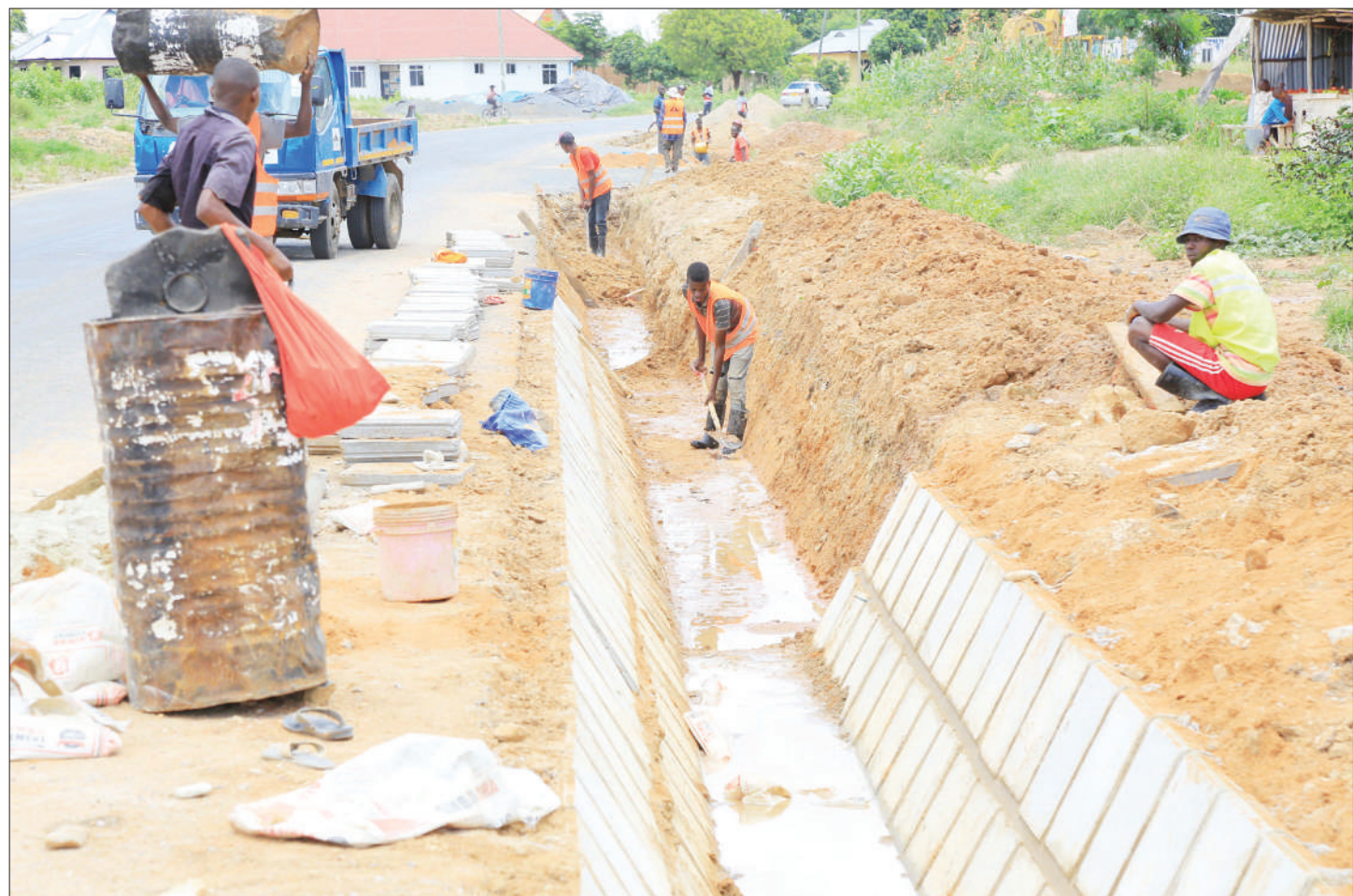
Mafundi wakiendelea na ujenzi wa mtaro wa kupitisha maji ya mvua katika Barabara ya Martin Luther, eneo la Swaswa, jijini Dodoma jana.
