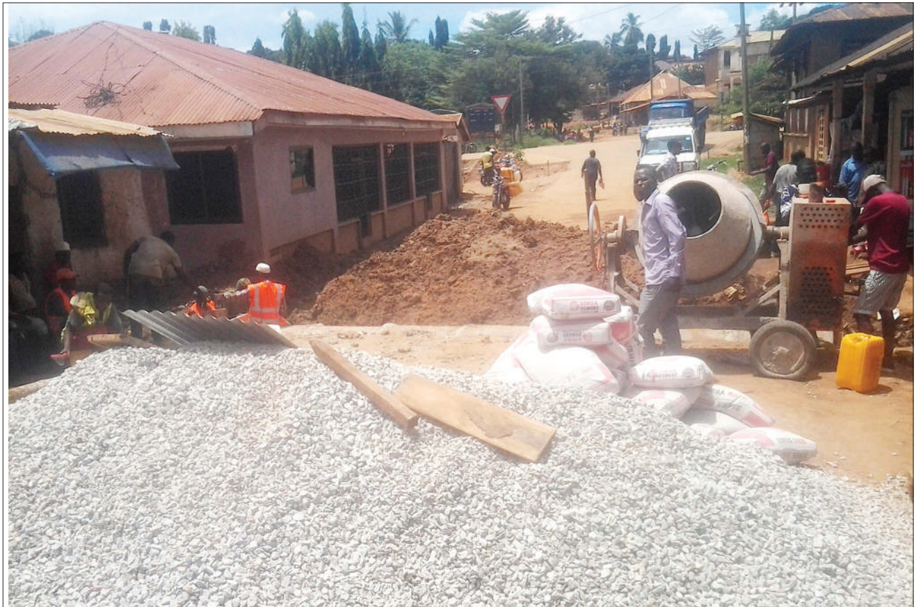
Mafundi wa kampuni ya Simac Ltd, wakiendelea na ujenzi wa karavati katika barabara yenye urefu wa kilomita moja inayojengwa kwa kiwango cha lami kutoka Hoteli ya Kilimanjario hadi Hospitali Teule ya Wilaya ya Muheza, mkoani Tanga juzi. PICHA: STEVEN WILLIAM
