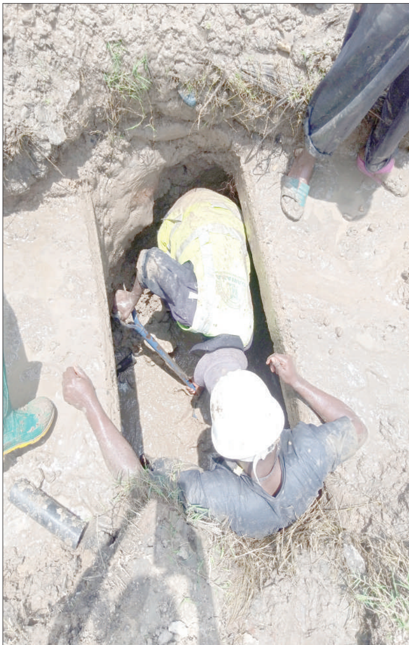
Mafundi wa Mamlaka ya Majisafi na Usafi wa Mazingira Dar es Salaam (DAWASA), wakiendelea na matengenezo ya bomba chakavu eneo la Kawe, mkoani humo jana. Mamlaka hiyo, inaendelea kubadilisha mabomba chakavu ili kupunguza kiwango cha maji yanayopotea. PICHA: MPIOGAPICHA WETU
