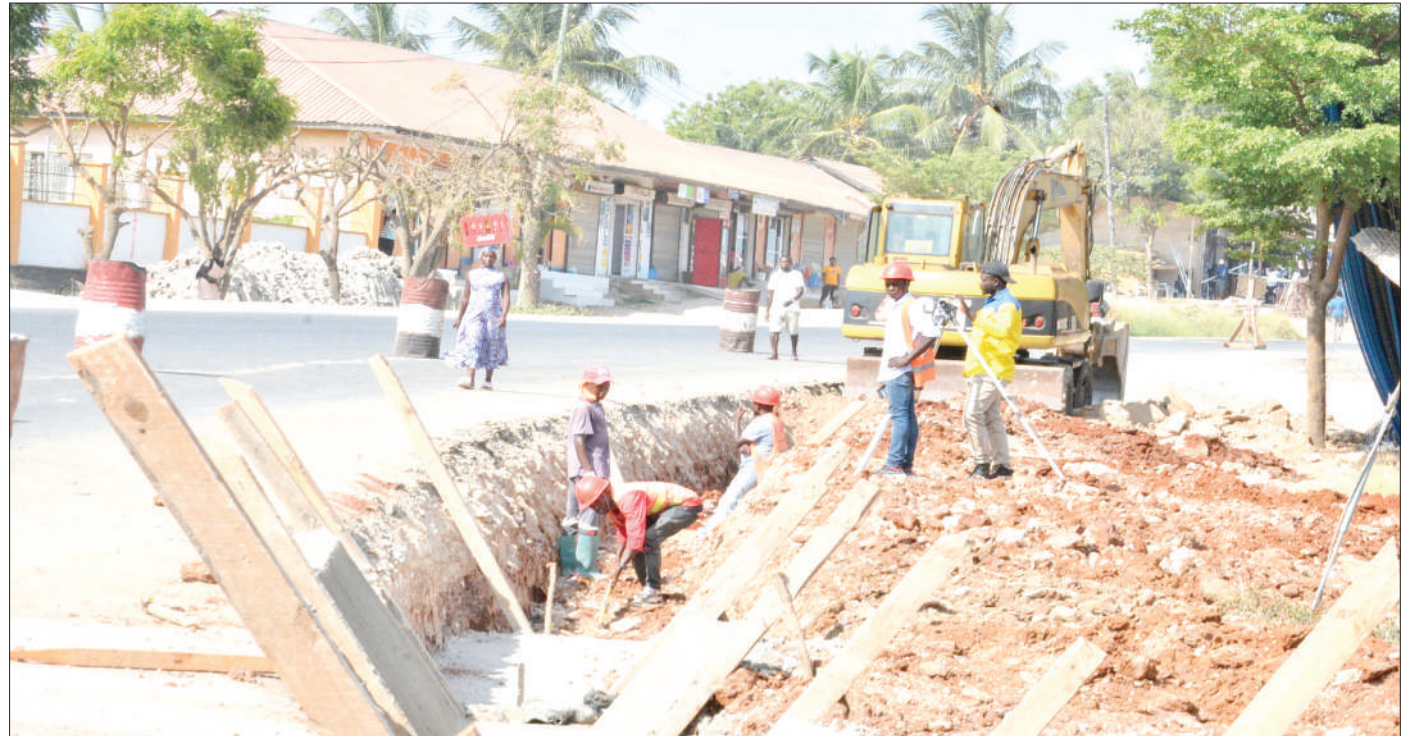
Mafundi wa kampuni ya ujenzi ya MECCO, wakiweka mifereji ya maji eneo la Kontena Mivumoni, katika ujenzi unaoendelea wa barabara ya Wazo hadi Madale kwa kiwango cha lami, Manispaa ya Kinondoni, Mkoa wa Dar es Salaam jana. PICHA: MIRAJI MSALA
