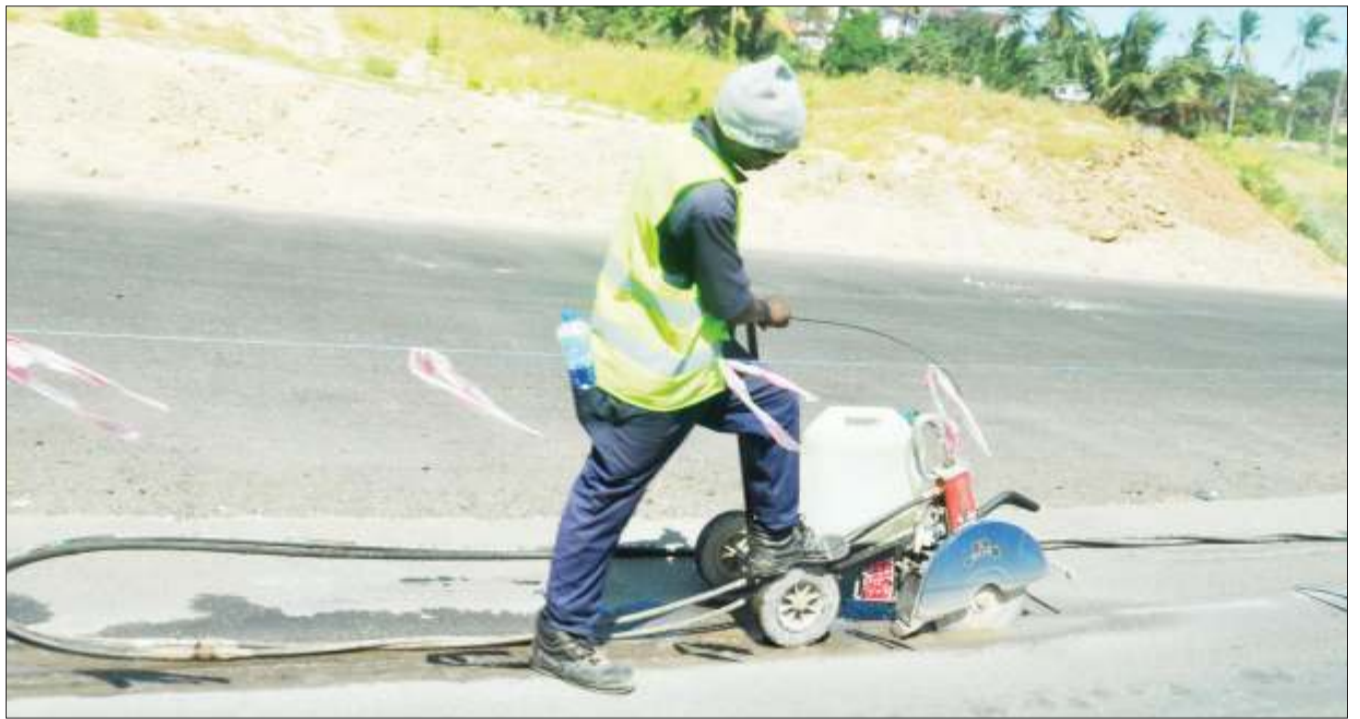
Fundi wa kampuni ya Estim, akiendelea na ujenzi wa upanuzi wa Barabara ya Morogoro, katika eneo la Kimara Stop Over, jijini Dar es Salaam jana, itakayojengwa kwa njia sita kuanzia Kimara hadi Kibaha mkoani Pwani. PICHA: JOHN BADI
