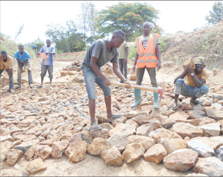
Mafundi ujenzi wa barabara wakidhibiti maeneo korofi katika mji wa Songe, Kilindi mkoani Tanga, barabara inayotoka makao makuu ya wilaya hiyo kwenda Gairo mkoani Morogoro. PICHA: DEGE MASOLI.
