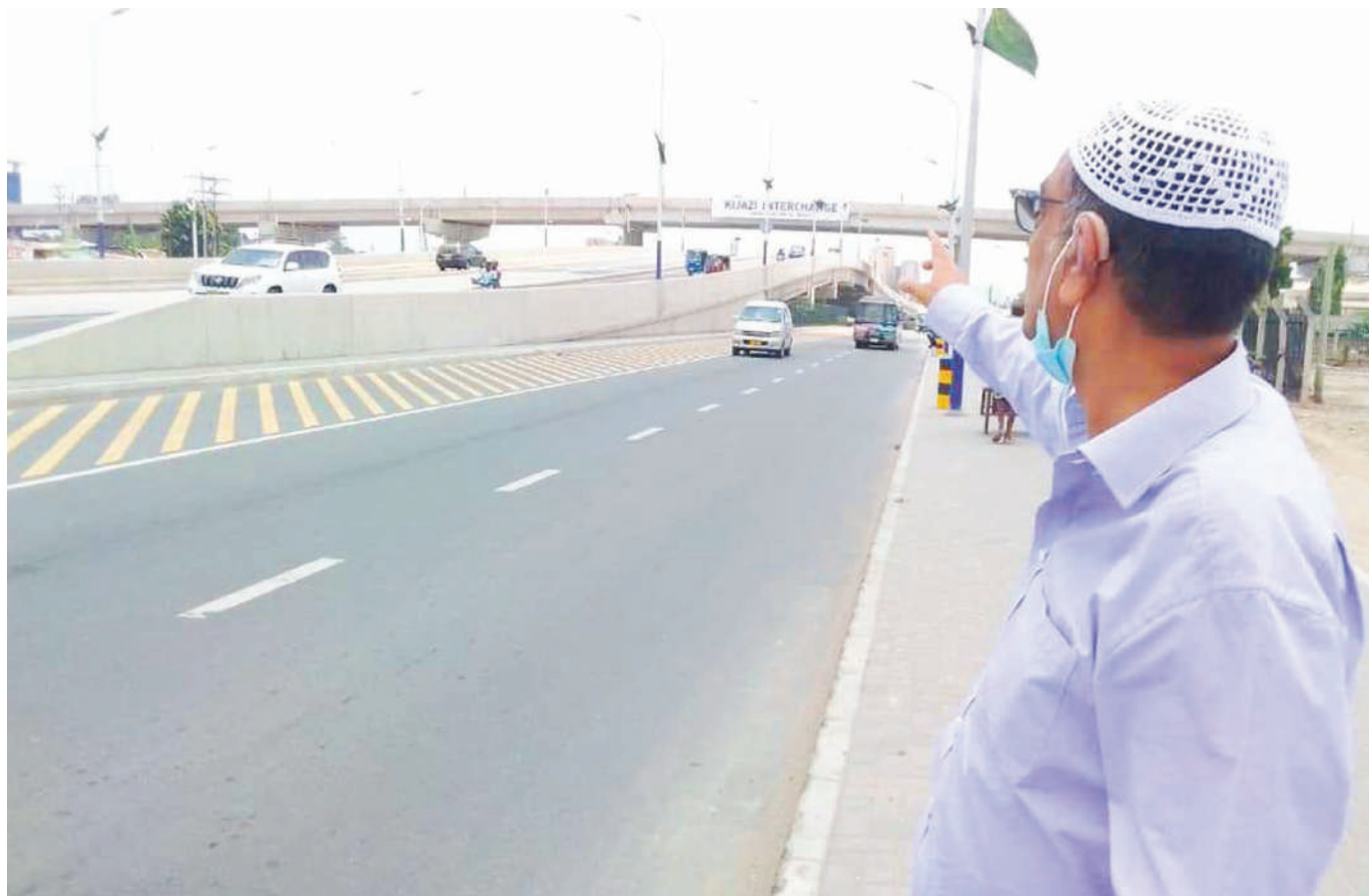
Mkurugenzi Mkuu wa kampuni ya Tanzania Building Works, Mhandisi Mohamed Noray, akifafanua jambo kwa waandishi wa habari, alipotembelea mradi wa daraja la juu la Kijazi (Kijazi Interchange), katika makutano ya barabara za Morogoro, Sam Nujoma na Mandela, eneo la Ubungo, mkoani Dar es Salaam. PICHA: ANAELI MBISE
