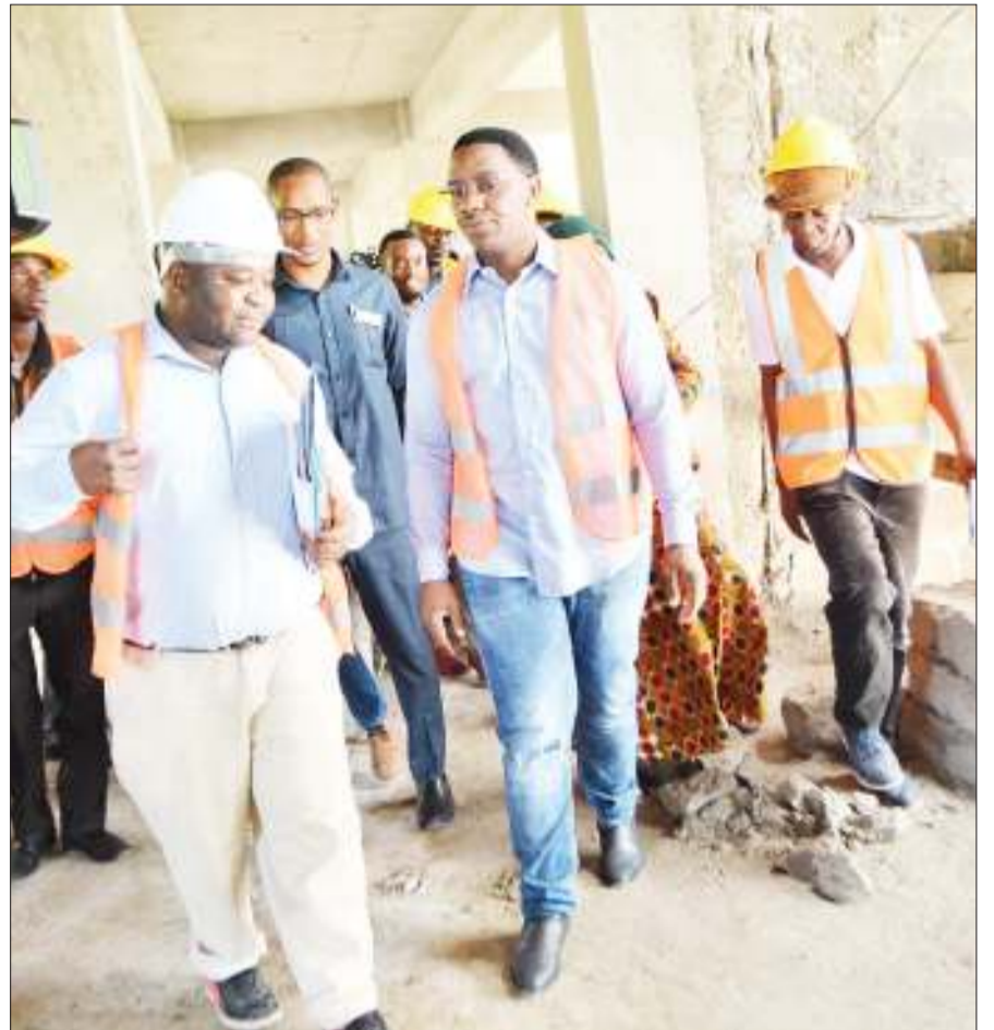
Mkuu wa Mkoa wa Dar es Salaam, Paul Makonda (wa pili kulia), akikagua mradi wa wodi mpya za wazazi katika Hospitali ya Mwananyamala, jijini Dar es Salaam jana, uliogharamu Sh. bilioni 2.1. Kushoto ni mhandisi wa kampuni iliyoshika kandarasi ya Mist Engineering (MISTECO), Moses Moyo. PICHA: MIRAJI MSALA
