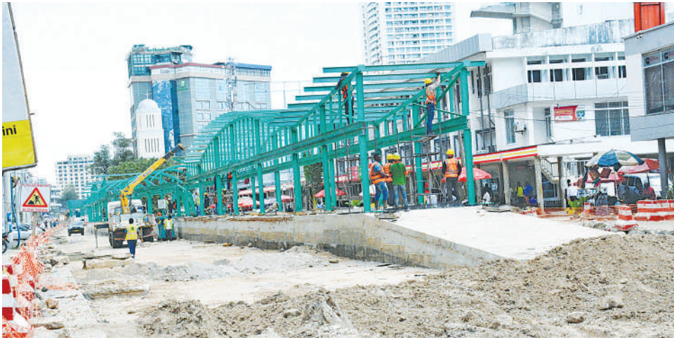
Mafundi wa mkandarasi wakiendelea na ujenzi kituo cha mabasi yaendayo haraka katika eneo la Posta Mpya, jijini Dar es Salaam jana. PICHA: MIRAJI MSALA
