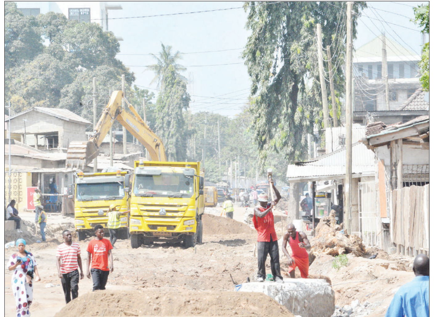
Kazi ya ujenzi wa barabara ya Mwananyamala mkoani Dar es Salaam ikiwa inaendelea katika eneo hilo. PICHA: MIRAJI MSALA
