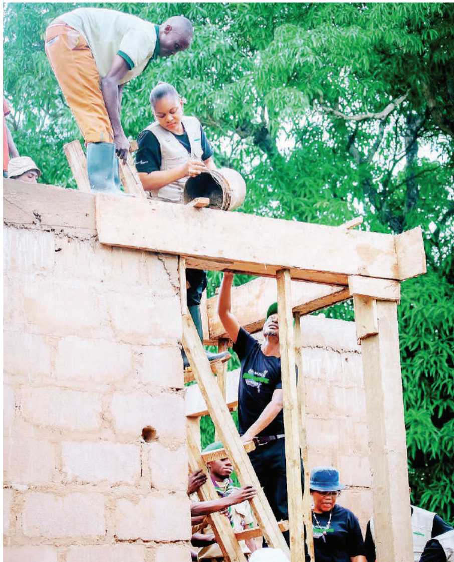
Mkuu wa Wilaya ya Korogwe mkoani Tanga, Jokate Mwegelo, akimwaga zege wakati wa ujenzi wa nyumba ya walimu katika Shule ya Msingi Magila Gereza, alipofanya ziara ya kukagua miradi mbalimbali wilayani humo jana. PICHA: MPIGAPICHA WETU
