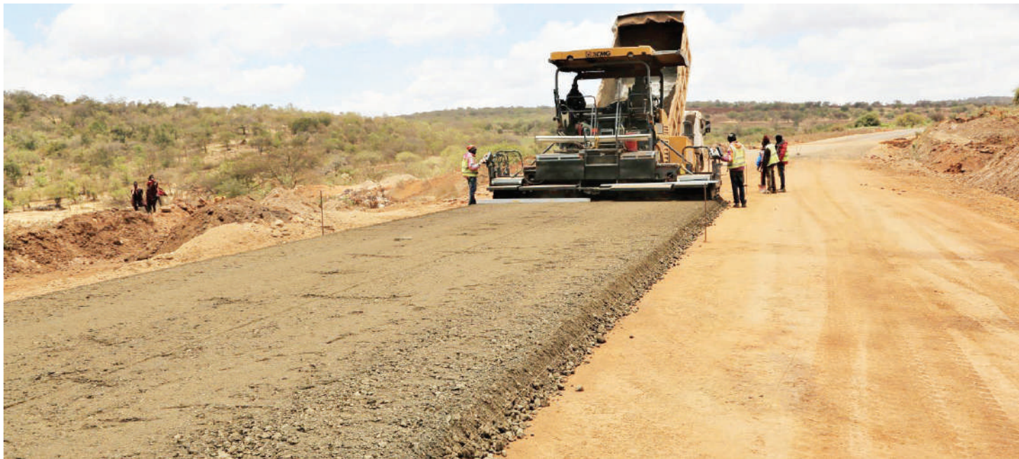
Kazi za ujenzi wa barabara kilomita 217, Loliondo hadi Mto wa Mbu, eneo kati ya Wasso hadi Sale (km 49), zilipokuwa zinaendelea Septemba mwaka jana, mkoani Arusha. PICHA: MTANDAO
