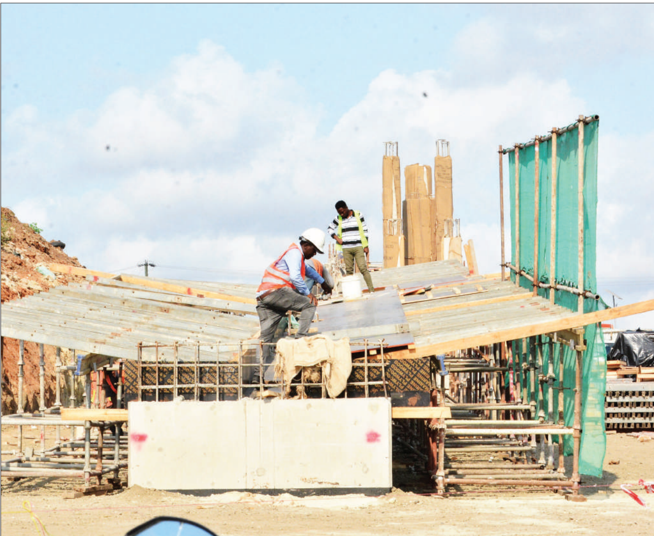
Mafundi wakiendelea na kazi ya kujenga kivuko kwa ajili ya waenda kwa miguu katika eneo la Mbezi Mwisho, jijini Dar es Salaam jana. PICHA: MIRAJI MSALA
