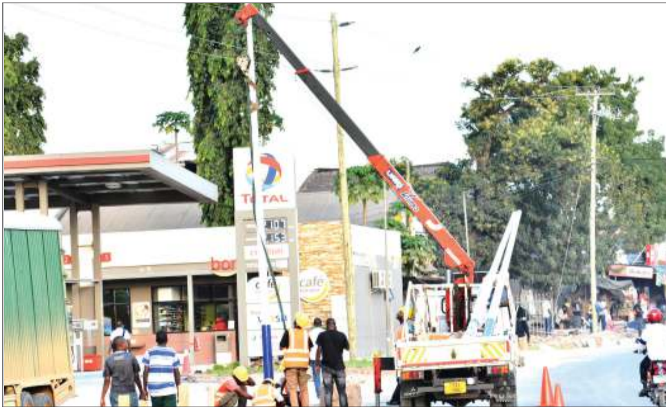
Mafundi wakiweka taa za barabarani zinazotumia nishati ya jua katika eneo la Sokota, Manispaa ya Temeke jijini Dar es Salaam wikiendi. Picha: MIRAJI MSALA
