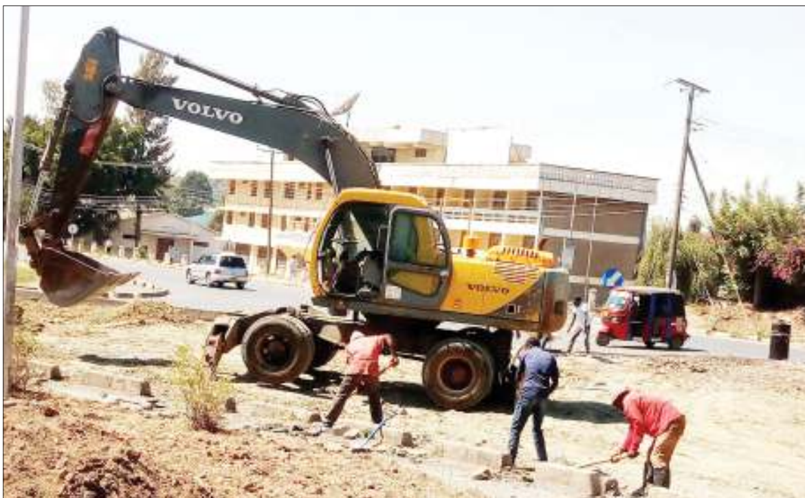
Mafundi wakiendelea na ukarabati wa barabara katiwa eneo la jirani na Uwanja wa Sokoine, jijini Mbeya jana, mahali ambapo ni maku-tano ya barabara za Karume na Mbeya-Chunya. PICHA: NEBART MSOKWA
