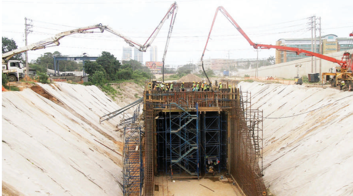
Mafundi wa Kampuni ya Ujenzi ya Yapi Merkezi, wakitumia mitambo kumwaga zege katika ujenzi wa daraja eneo la Chang'ombe jijini Dar es Salaam jana. PI-CHA: JUMANNE JUMA
