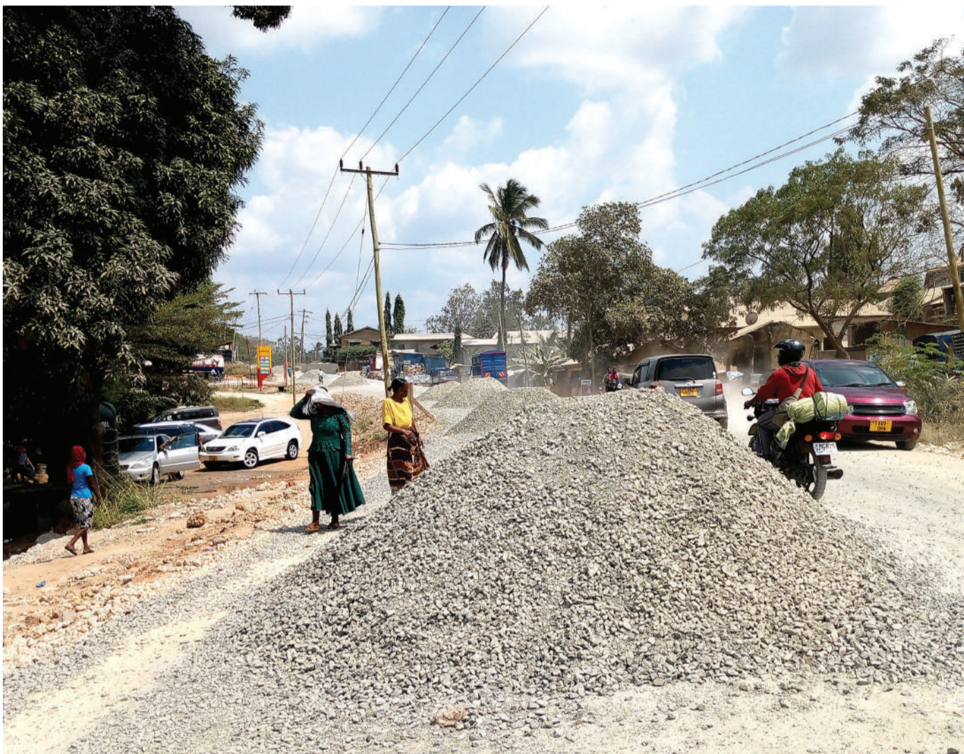
Kokoto zikiwa zimewekwa katikati ya barabara ya kwenda Msumi, eneo la Mbezi Makabe, Manispaa ya Ubungo, Dar es Salaam jana, ikiwa ni maandalizi ya ujenzi wa barabara ya kiwango cha lami. PICHA: SABATO KASIKA
