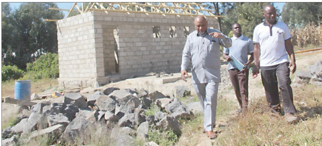
Meya wa Jiji la Mbeya, Dour Issa Mohamed (kushoto), akiwa na baadhi ya viongozi wa Bodi ya Shule ya Sekondari Iduda ya jijini humo, kukagua ujenzi wa miundombinu unaoendelea shuleni hapo, hivi karibuni. PICHA: NEBART MSOKWA
