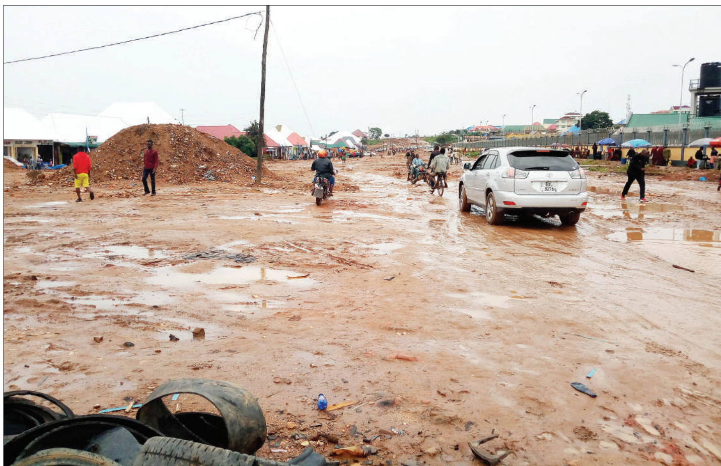
Mwonekano wa eneo la wazi kwenye mpaka wa Tanzania na Zambia mjini Tunduma, mkoani Songwe jana, baada ya nyumba zilizokuwa zimejengwa na wananchi kubomolewa kwa makubaliano ya serikali za nchi hizo mbili na kuzuia shughuli zingine kufanyika. PICHA: NEBART MSOKWA
