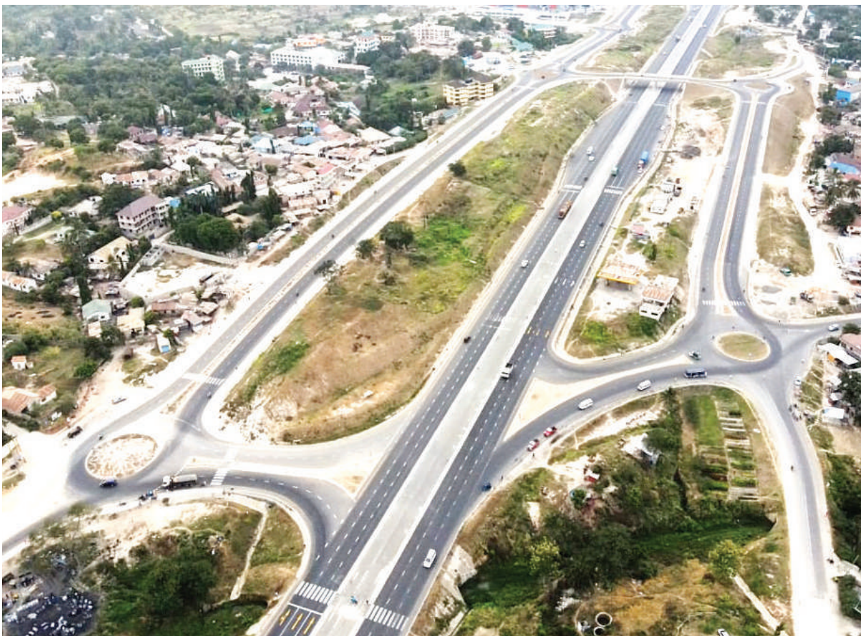
Mwonekano wa sehemu ya Barabara ya Morogoro ya njia nane kutoka Kimara hadi Kibaħa (km 19.2), jijini Dar es Salaam jana. Ujenzi wa barabara hiyo, umefikia asilimia 98 na unatarajia kukamilika mwishoni mwa Aprili, 2023. PICHA: WUU
