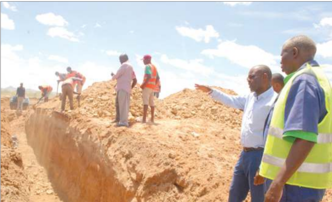
Waziri wa Maji na Umwagiliaji, Prof. Makame Mbarawa (wa pili kulia), akitoa maelekezo kwa mafundi wanaochimba mtaro wa bomba kuu la maji yatakayotumika kwenye majengo yanayojengwa mji wa kiserikali uliopo Mtumba, jijini Dodoma jana. PICHA: PETER MKWAVILA
