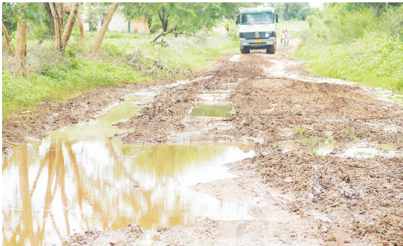
Mwonekano wa ubovu wa barabara ya kutoka Chuo cha Ufundi Stad Veta Manispaa ya Shinyanga, kwenda Kijiji cha Lyandu katika manispaa hiyo, namna ilivyoharibiwa na mvua, huku wananchi pamoja na magari yakipata shida kupita kwenye barabara hiyo mwishoni mwa wiki. PICHA: MARCO MADUHU
