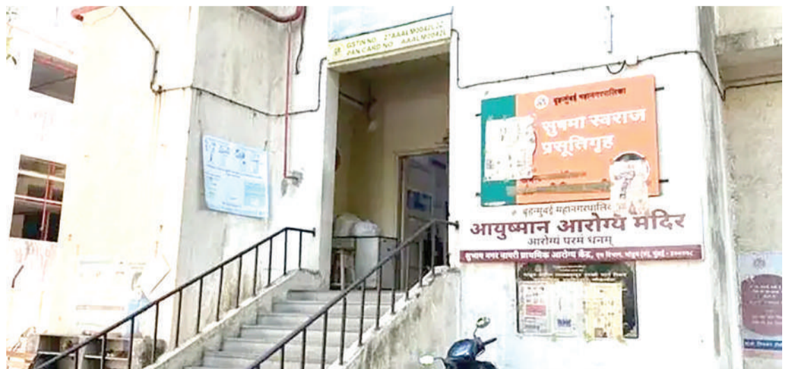
Sehemu ya jengo la hospitali hiyo iliyoko Mumbai, India. Picha zote: MTANDAO
