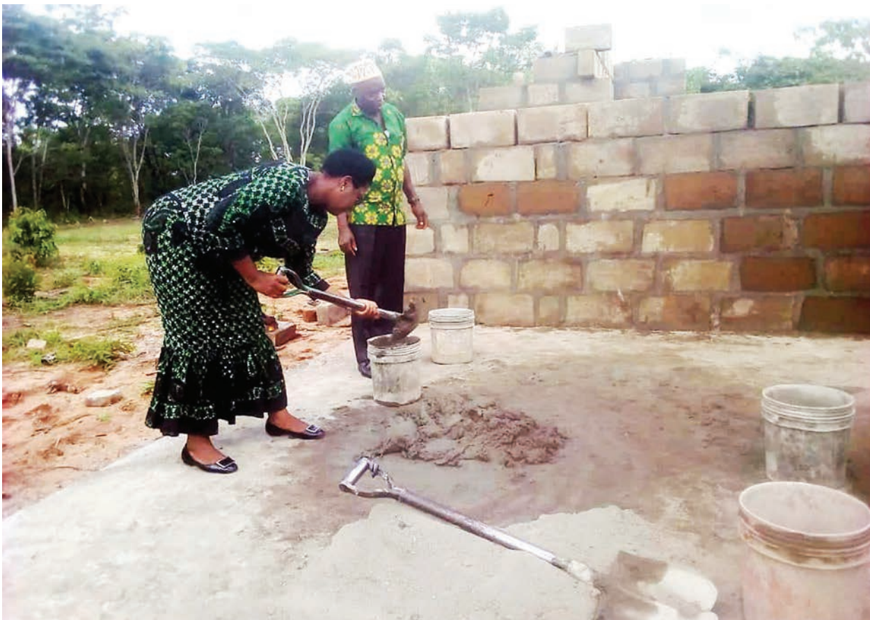
Mkuu wa Wilaya ya Liwale, mkoani Lindi, Judith Nguli, akishiriki ujenzi wa Kituo cha Afya cha Kata ya Barikiwa, alipokwenda kukagua maendeleo ya ujenzi wa kituo hicho, juzi. Anayeshuhudia ni Mwenyekiti wa CCM wa Wilaya hiyo, Mohamed Kitura. PICHA: MPIOGAPICHA WETU
