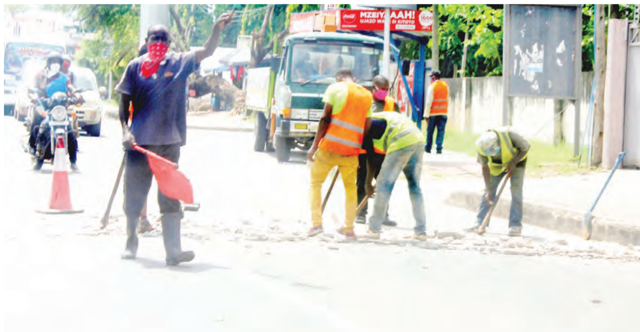
Mafundi wakiifanyia ukarabati barabara ya Umoja wa Mataifa, kutokana na kuharibika katika eneo la Upanga Magharibi, jijini Dar es Salaam jana. PICHA: JUMANNE JUMA
