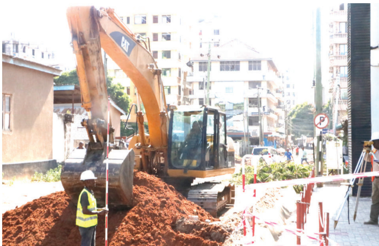
Mafundi wakipima barabara za mitaa katika eneo la Lumumba jijini Dar es Salaam jana, kwa ajili ya kuanza ujenzi wa lami. Picha: JUMANNE JUMA
