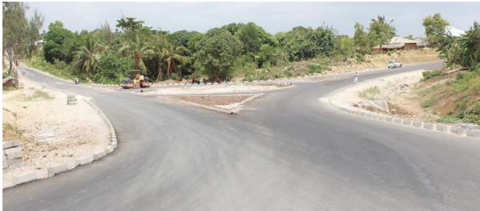
Ujenzi wa barabara mpya ya lami kisiwani Pemba, makutano ya Mabao kuelekea Kengeja na Uwanja wa Ndege wa Karume, Chakechake. PICHA: MTANDAIO.
