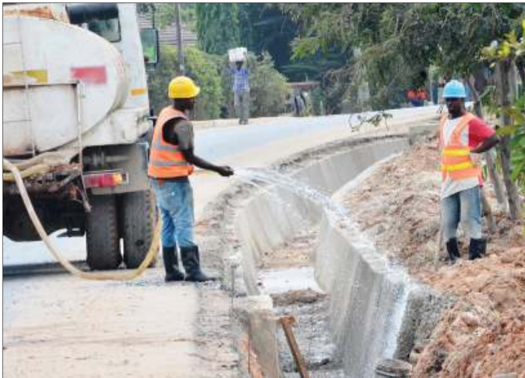
Mafundi wa ujenzi wakiendelea na kazi ya kumwagia maji kuta za mifereji inayoendelea kujengwa ili saruji ikauke katika eneo la Ubungo jijini Dar es Salaam jana. PICHA: MIRAJI MSALA
