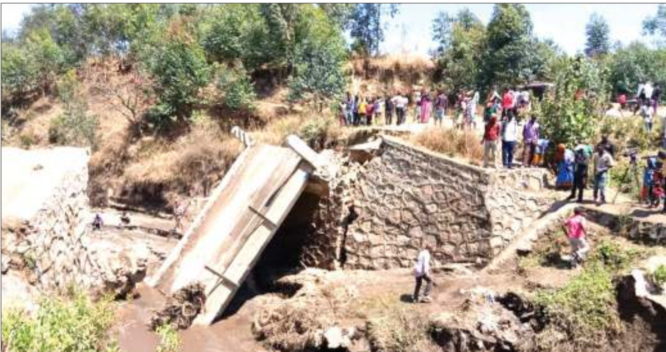
Wananchi wa Jiji la Mbeya, wakiangalia daraja linalounganisha Kata za Mwasanga na Mwakibete, baada ya kubomoka kutokana na mafuriko yaliyosababishwa na mvua zinazoendelea kunyesha jijini humo, juzi. PICHA: NEBART MSOKWA
