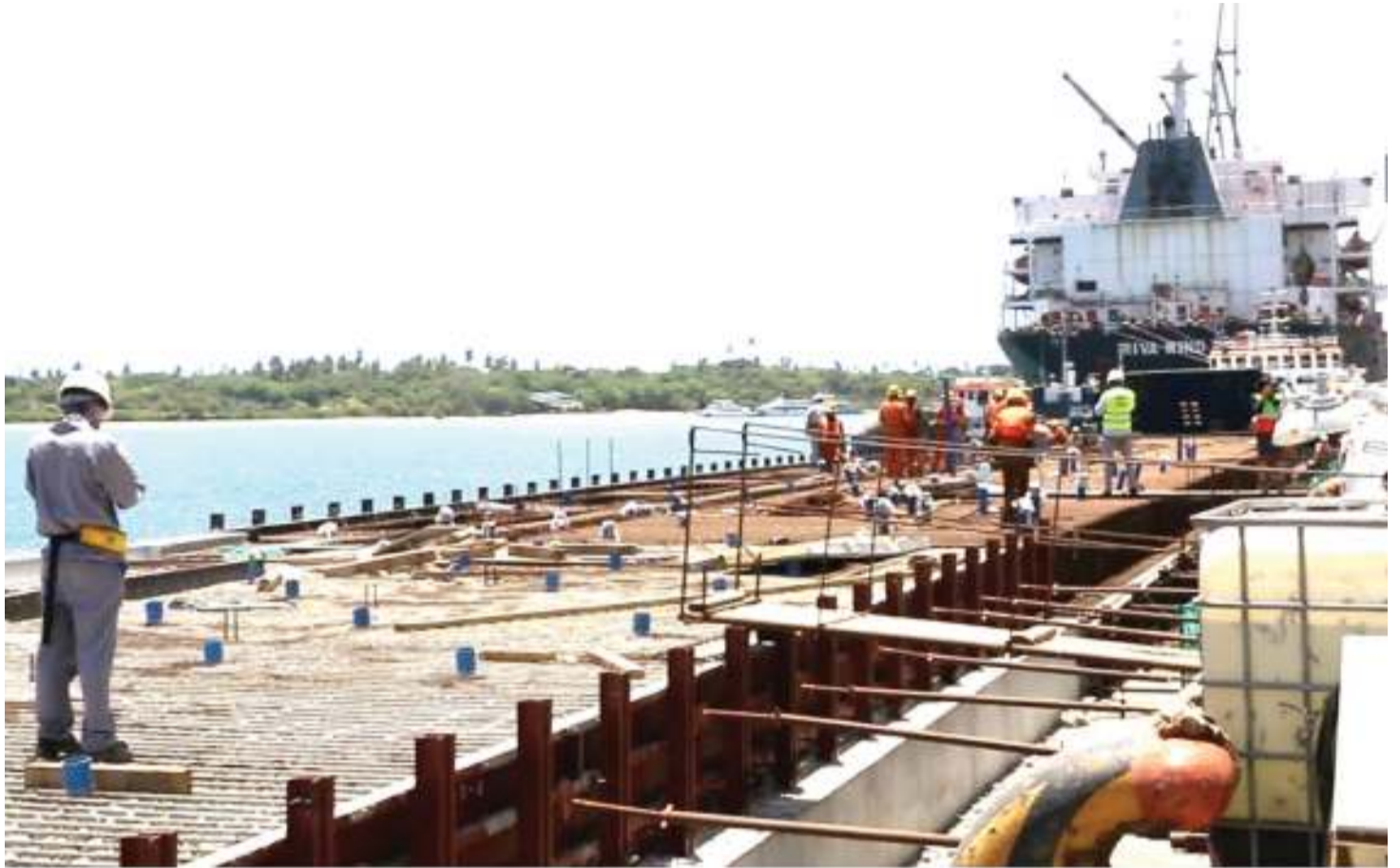
Sehemu ya ujenzi wa gati katika Bandari ya Dar es Salaam. Picha:MTANDAO
