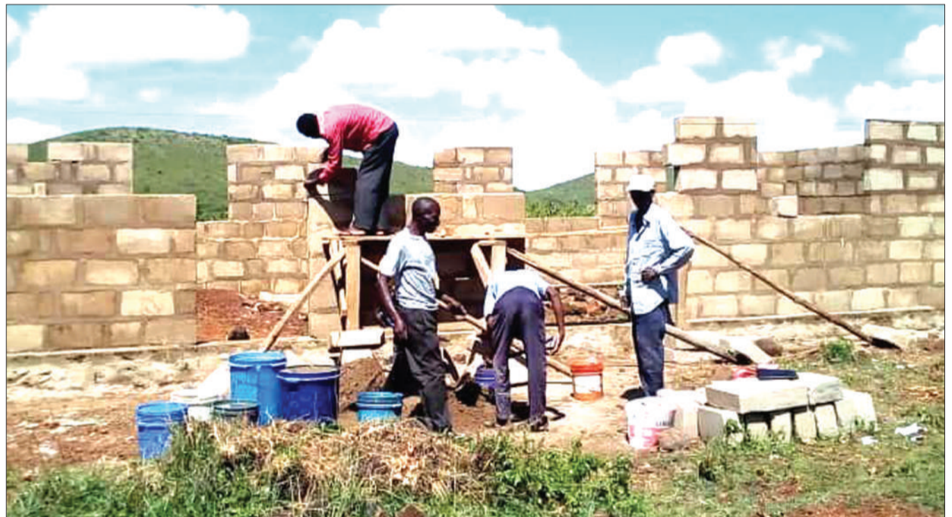
Baadhii ya wakazi wa Kitongoji cha Karuenyi Kijiji cha Mikuyu, Kata ya Nyamrandirira, Musoma Vijijini mkoani Mara, wakishirikiana na mafundi kujenga darasa la shule ya awali juzi, ili kuwapunguzia kutembea umbali mrefu kufuata elimu. Picha: SABATO KASIKA
