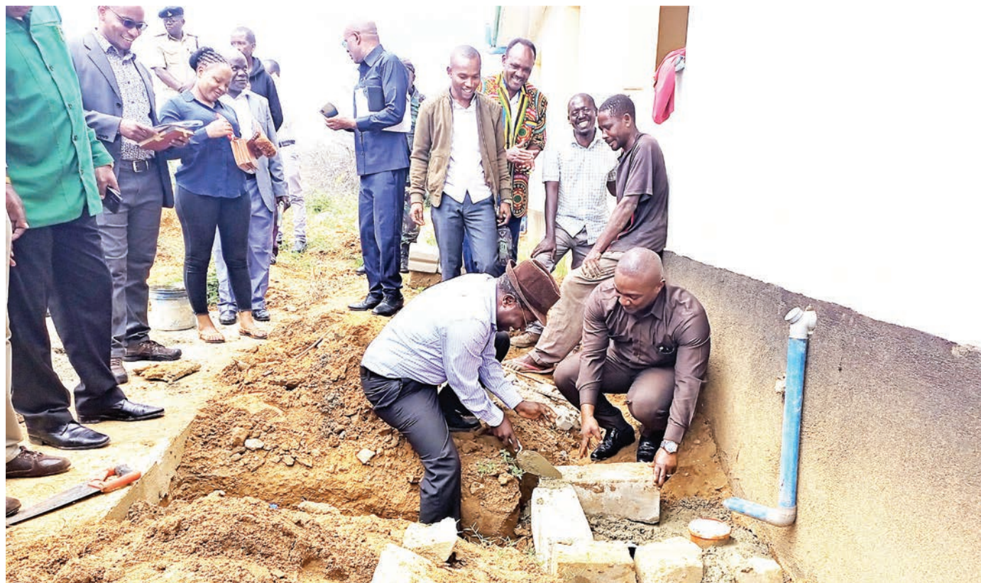
Waziri wa Nchi, Ofisi ya Rais, Menejimenti ya Utumishi wa Umma na Utawala Bora, Mohamed Mchengerwa (kulia) akishiriki shughuli za ujenzi wa karo kwenye Zahanati ya Nyabilezi iliyojengwa kwa ufadhili wa Mfuko wa Maendeleo ya Jamii (TASAF) wakati wa ziara yake ya kikazi ya kukagua utekelezaji wa miradi ya mfuko huo wilayani Chato, mkoani Geita. Anayeshirikiana naye ni Mbunge wa Jimbo la Chato, Medard Kalemami. PICHA: JAMES MWANAMYOTO
