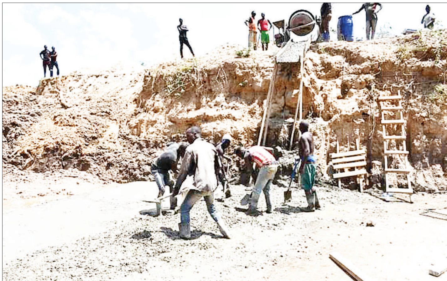
Wananchi wa vijiji vya Ukwavila na Uturo, katika Halmashauri ya Wilaya ya Mbarali, mkoani Mbeya, wakiendelea na ujenzi wa banio la skimu ya umwagiliaji jana, ambapo kwa nguvu zao wamechangia kiasi cha Sh. milioni 175, zinazohitajika ni Sh. milioni 220 ili ujenzi huo ukamilike.
