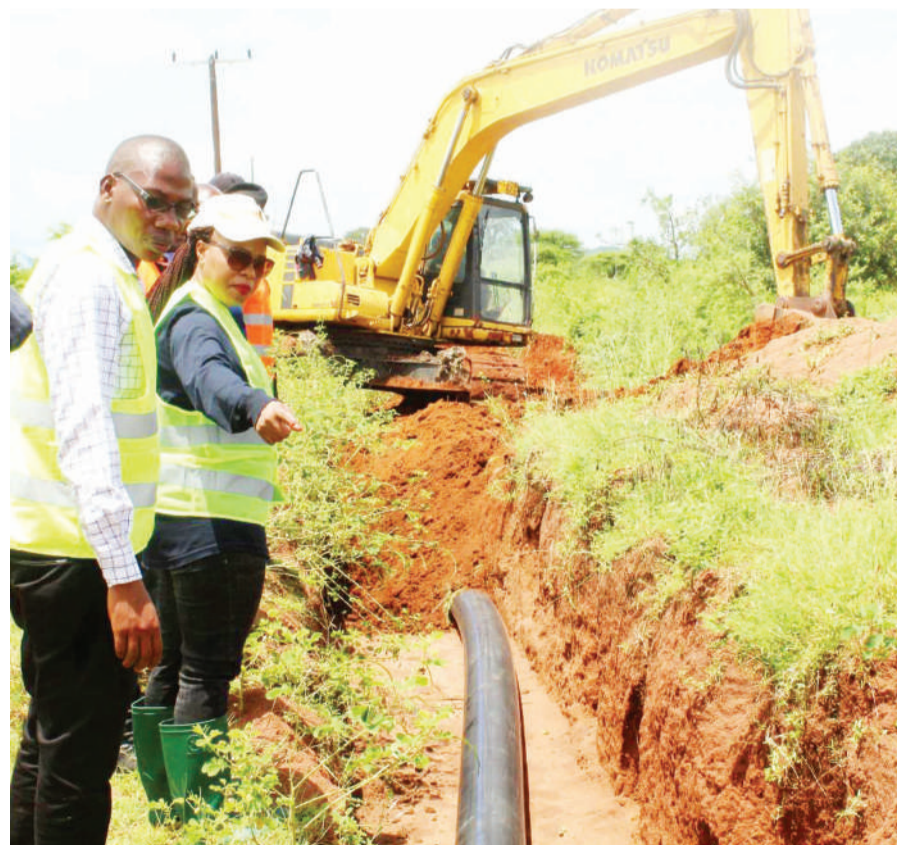
Mkuu wa Wilaya ya Shinyanga, Jasinta Mboneko (wa pili kushoto), akiwa na Kaimu Meneja wa Ruwasa, Emmanuel Nkopi, kukagua ufukaji mabomba, kwenye mradi wa maji Kata ya Masengwa. Picha zote: Marco Maduhu
