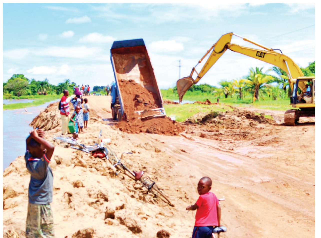
Sehemu ya barabara ya Malinyi katika kijiji cha Misegese eneo la Mwembeni mkoa wa Morogoro, ikiwa imetengenezwa tuta ili kuzuia maji kupita juu ya barabara hiyo iliyoharibika kutokana na mafuriko ya mto Furua, huku kazi nyingine za ukarabati wa barabara hiyo zikiendelea. PICHA: MPIGAPICHA WETU
