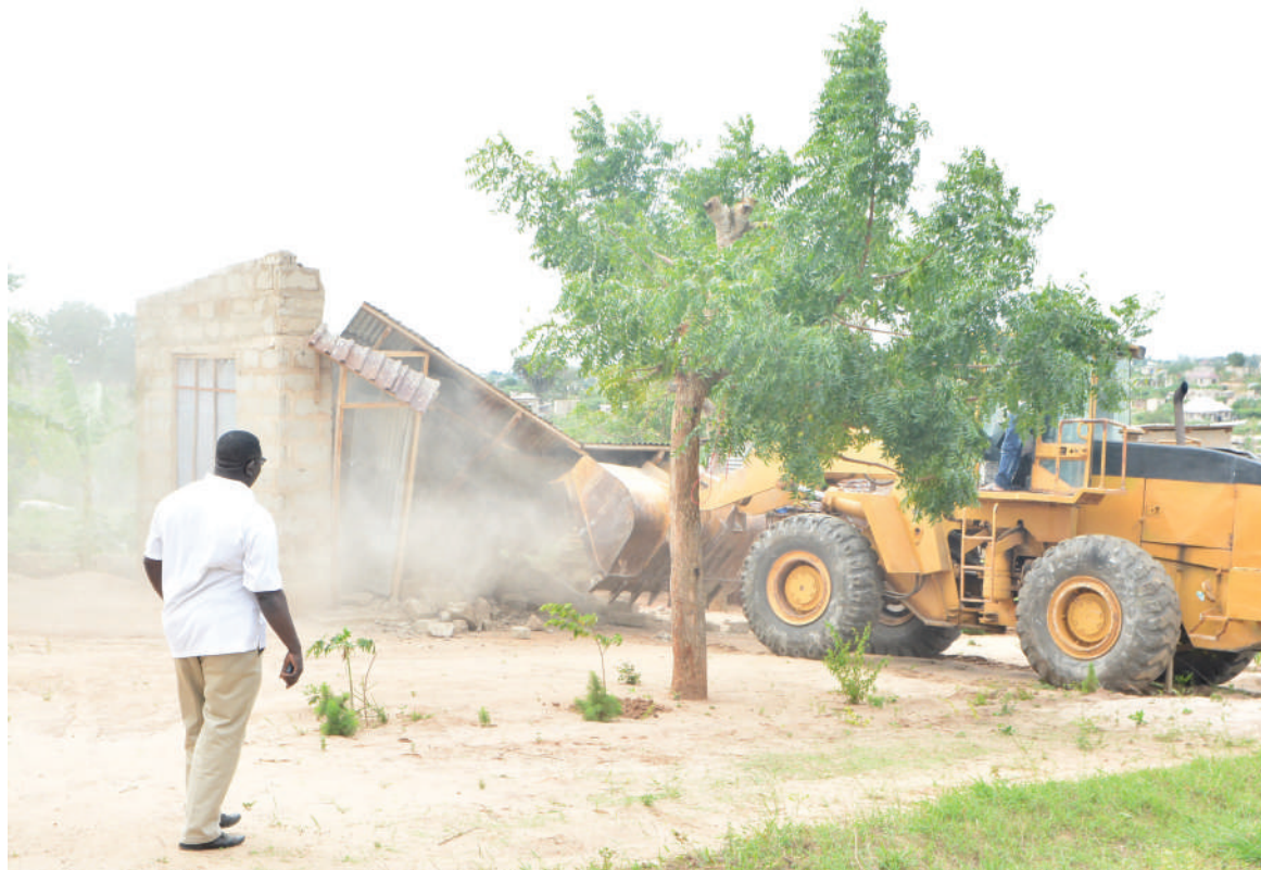
Askari akisimamia ubomoaji wa nyumba katika eneo la Kimbesa Mpijimohe Manispaa ya Ubungo mkoani Dar es Salaam jana. Picha: MIRAJI MSALA
