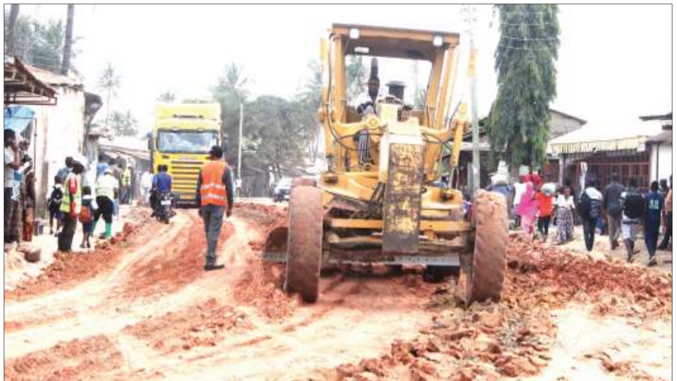
Katapila la kampuni ya ukandarasi likichonga barabara ya Kitunda yenye urefu wa kilomita 3, jijini Dar es Salaam jana, kwa ajili ya ujenzi wa kiwango cha lami. PICHA: JUMANNE JUMA
