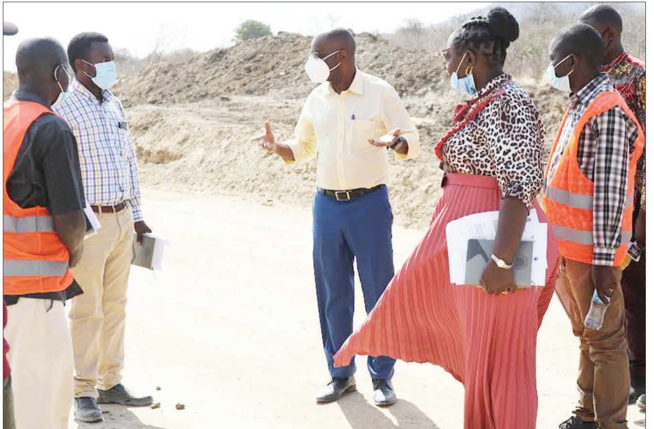
Waziri wa Ujenzi na Uchukuzi, Prof. Makame Mbarawa (katikati), akifafanua jambo kwa makandarasi wa kampuni ya Inter-Consult Ltd, inayojenga barabara ya mzunguko ya urefu wa kilometa 112.3, jijini Dodoma, wakati alipokuwa akikagua maendeleo ya ujenzi wa mradi huo. PICHA: PAUL MABEJA
