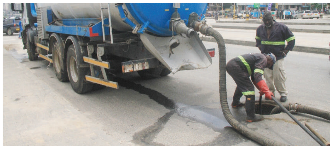
Wafanyakazi wa Mamlaka ya Majisafi na Usafi wa Mazingira Dar es Salaam (DAWASA), wakizibua mtaro wa maji machafu katika Barabara ya Morogoro, eneo la Lumumba, jijini Dar es Salaam jana. PICHA: JUMANNE JUMA
