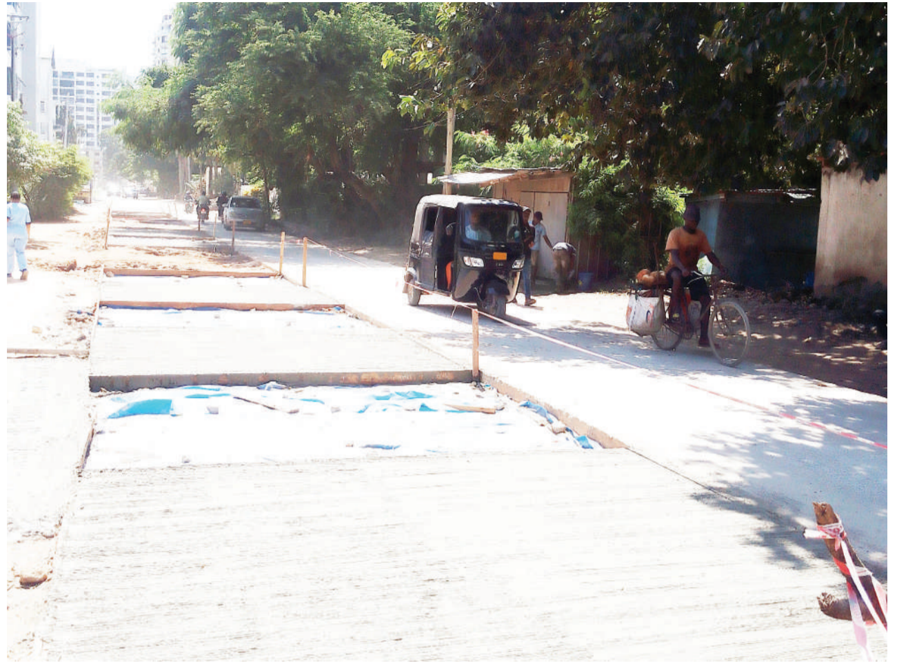
Sehemu ya Barabara ya Mtaa wa Kalenga, Upanga Magharibi, jijini Dar es Salaam, ikiwa imeanza kujengwa kwa kiwango cha zege jana, kutokana na kuharibika mara kwa mara hasa nyakati za mvua. PICHA: JOHN BADI
