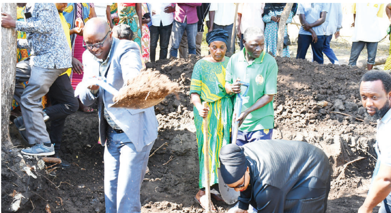
Mkuu wa Mkoa wa Shinyanga Dk. Philemon Sengati, akishiriki katika kuchimba shimo kwa ajili ya ujenzi wa matundu ya choo cha Shule ya Sekondari Ngokoro iliyoko Manispaa ya Shinyanga kuadhimisha siku 100 za uongozi wa serikali ya awamu ya sita. NA MPIGAPICHA WETU
