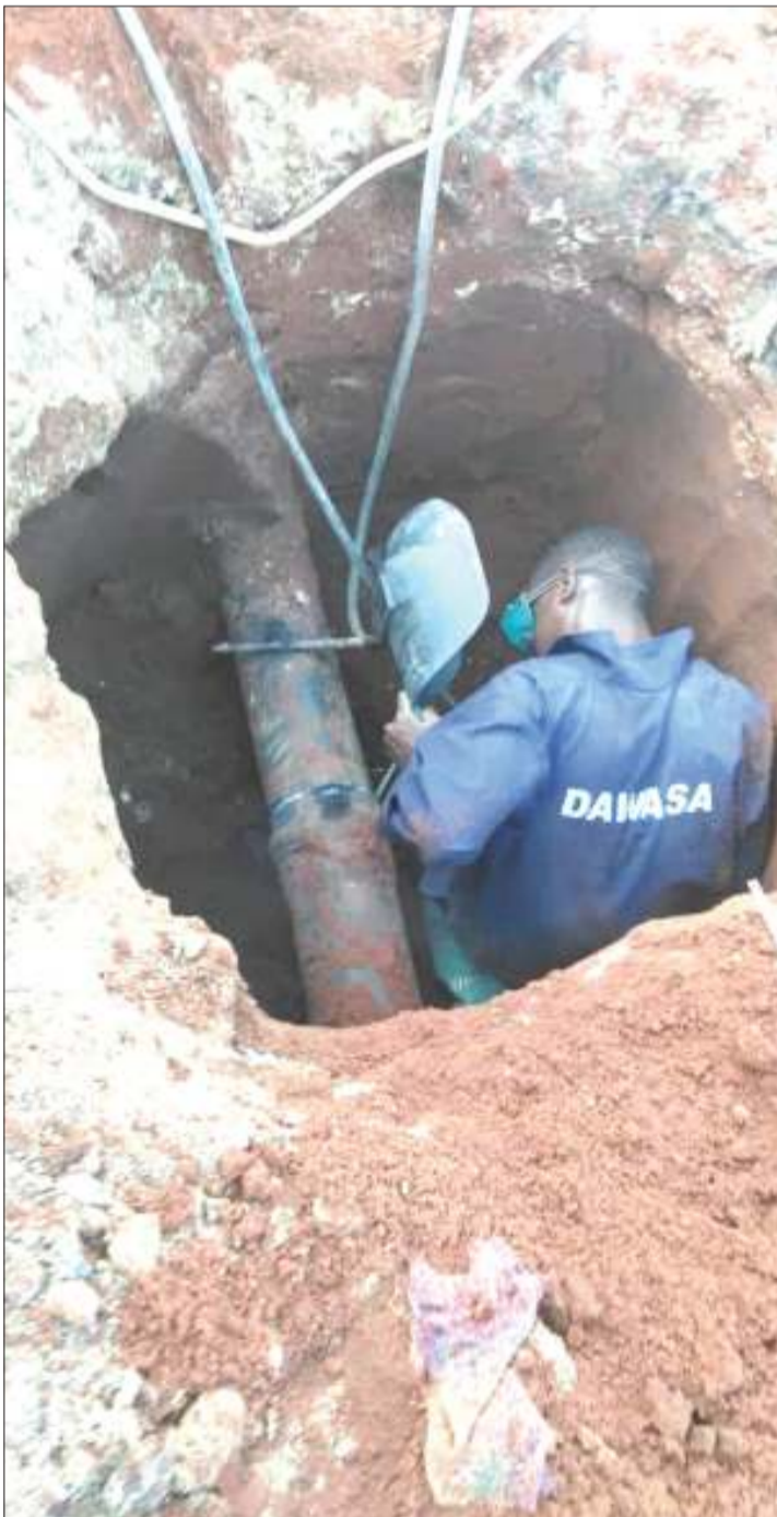
Fundi wa Mamlaka ya Majisafi na Majitaka Dar es Salaam (DAWASA) Mkoa wa huduma wa Tegeta, akichomelea bomba kudhibiti uvujaji wa maji katika njia panda ya Kunduchi, jijini humo jana. PICHA: MPIGA PICHA WETU
