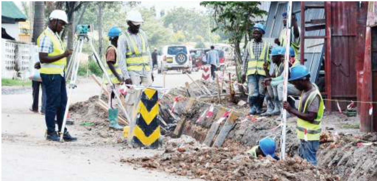
Mafundi wakiendelea na ujenzi wa mifereji ya majitaka katika Mtaa wa Papa Sinza, jijini Dar es Salaam jana. Picha: MIRAJI MSALA.
