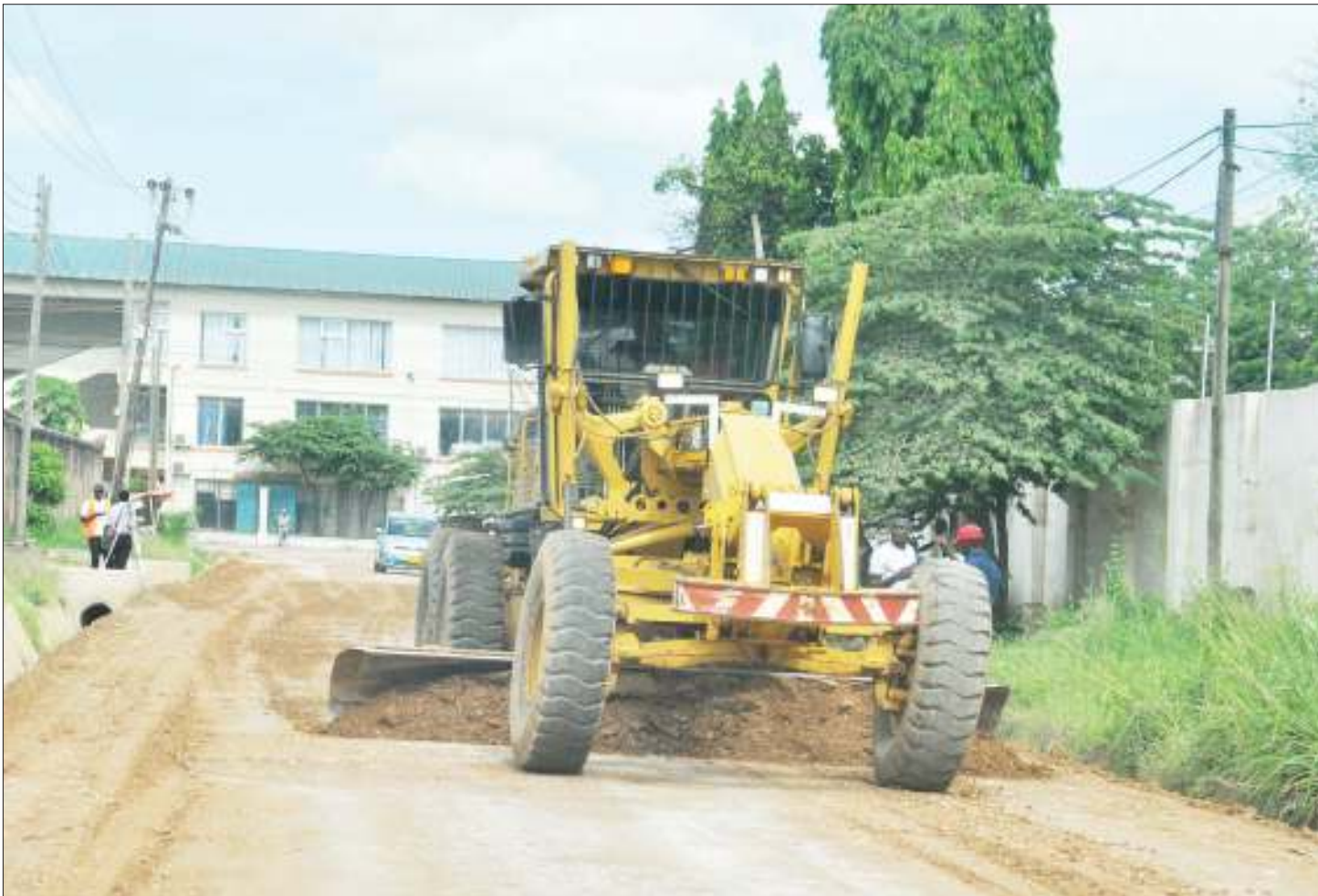
Katapila la mkandarasi likiendelea na kazi ya ukarabati wa Barabara ya Sewa, eneo la Mikocheni Viwandani, jijini Dar es Salaam jana. PICHA: JOHN BADI
