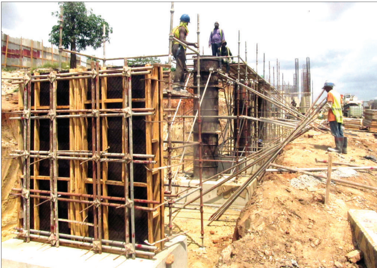
Mafundi wakijenga daraja la waenda kwa miguu, eneo la Mbezi Mwisho, jijini Dar es Salaam jamaa, ambalo litatumiwa na abiria watakotoka na kuingia kwenye kituo kipya cha mabasi ya mikoani kinachojengwa eneo hilo. PICTA: SABATO KASIKA
