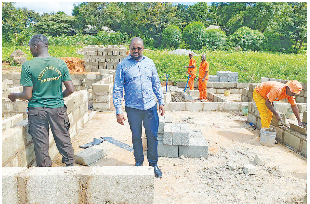
Mbunge wa Jimbo la Moshi Mjini, Priscus Tarimo (wa pili kushoto), akikagua maendeleo ya ujenzi wa kituo cha polisi katika kata ya Karanga, Manispaa ya Moshi, mkoani Kilimanjaro mwishoni mwa wiki, kinachojengwa kwa nguvu za wananchi. PICHA: JAMES LANKA
