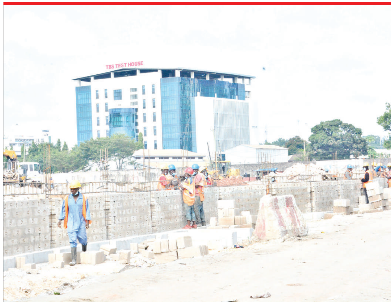
Mafundi wa kampuni ya ujenzi ya CCECC wakijenga ukuta katika eneo la Ubungo stendi ya mkoa, jijini Dar es Salaam jana. PICHA: MIRAJI MSALA
