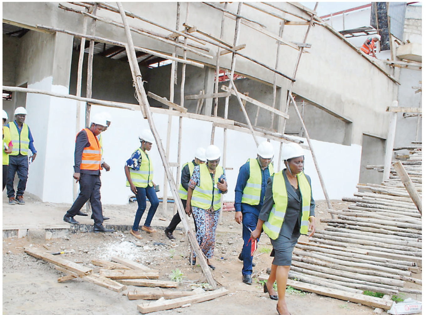
Naibu Katibu Mkuu wa Wizara ya Fedha na Mipango, Janifa Omolo (kulia), akikagua ujenzi wa majengo ya hosteli ya wanafunzi wa chuo cha mipango yanayoendelea kujengwa katika eneo la Miyuji, jijini Dodoma jana. Wengine ni Mkuu wa Chuo cha Mipango, Prof. Hozen Mayaya (wa pili kulia) na (wa tatu kulia) ni Mwenyekiti wa Baraza la uongozi wa chuo hicho, Prof. Martha Qorro. PICHA: PETER MKWAVILA
