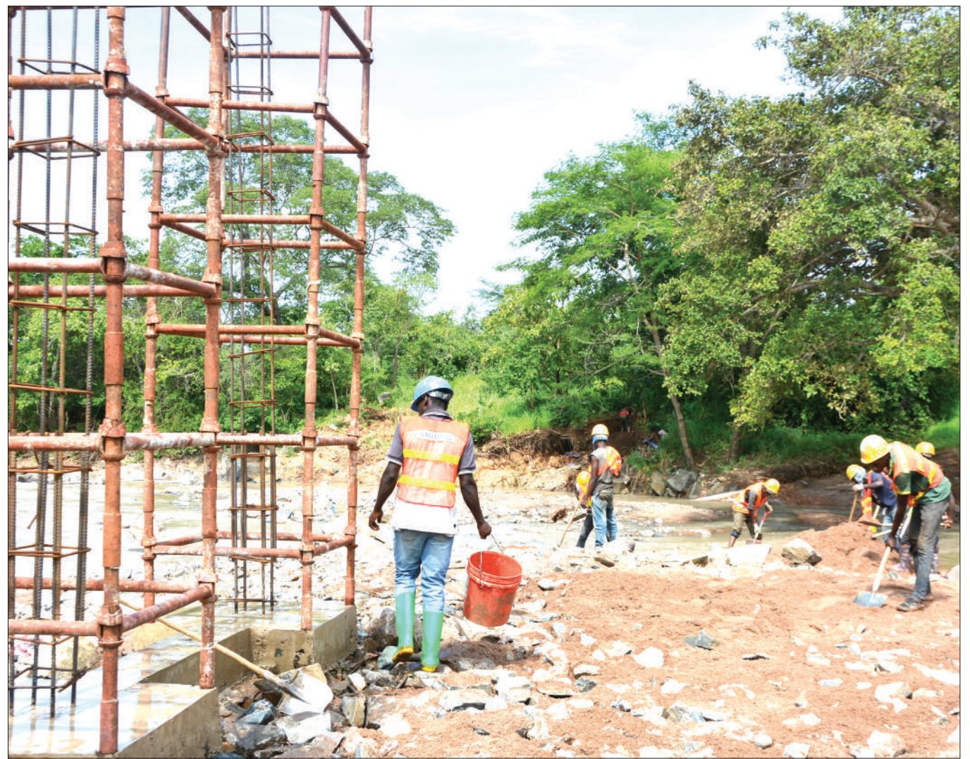
Wafanyakazi wa kampuni ya ukandarasi ya China Railway 15 Bureau Group Corporation, anayejenga barabara ya Chunya-Makongolosi yenye urefu wa Km 39, wakiendelea na kazi za ujajaji wa mawe na kifusi katika Daraja la Chipoka, mkoani Mbeya juzi. PICHA: WUUM
