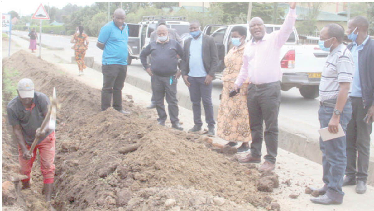
Mkurugenzi Mtendaji wa Mamlaka ya Maji Safi na Usafi wa Mazingira Mkoa wa Mbeya (Mbeya-UWSA), Ndele Mengo (wa tatu kulia), akiwaonyesha wajumbe wa Bodi ya wakurugenzi wa mamlaka hiyo, moja ya mitaro ambayo inaendelea kuchimbwa kwa ajili ya mabomba yatakayokuwa yanapeleka maji kwenye Kata za Isyesye, Itezi, Ilemi na Gombe. PICHA: NEBART MSOKWA
