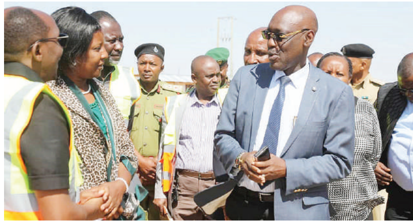
Mkuu wa Mkoa wa Dodoma, Rosemary Senyamule, akimsikiliza mratibu wa ujenzi wa uwanja mpya wa Mashujaa, Meshach Bandawe (kulia), alipotembelea mradi huo unaojengwa katika Mji wa serikali Mtumba jijini Dodoma jana. Uwanja huo unatarajiwa kukamilika Juni 30. PICHA: MPIGAPICHA WETU
