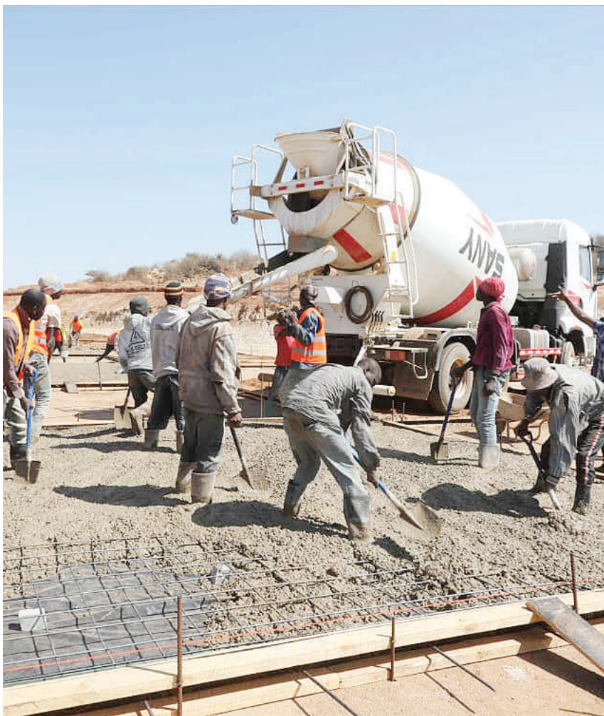
Mafundi wakiendelea na awamu ya kwanza ya ujenzi wa Uwanja wa Mashujaa, katika mji wa Kiserikali Dodoma, unaotarajiwa kukamilika Juni 30, mwaka huu. PICHA: MPIGAPICHA WETU
