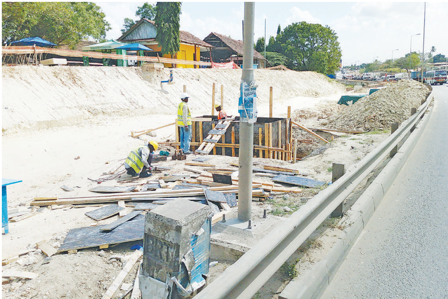
Mafundi wakiendelea na ujenzi wa upanuzi wa Barabara ya Morogoro, eneo la Kimara Resort, Dar es Salaam jana. PICHA: SABATO KASIKA
