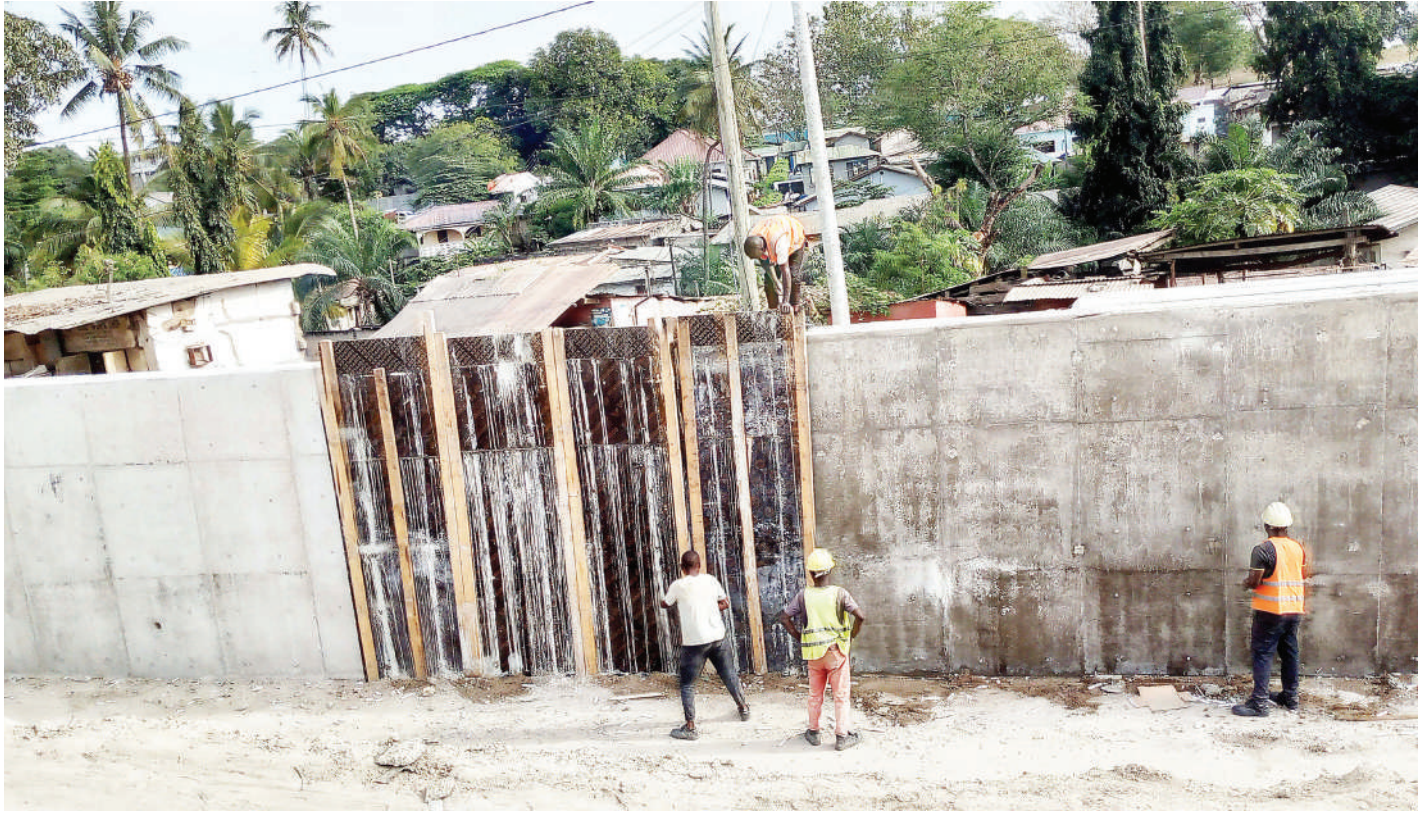
Baadhi ya mafundi wanaoboresha Barabara ya Morogoro, wakiondoa mbao kwenye ukuta uliojengwa, ili kuzuia mmonyo wa ardhi eneo la Kimara Resort, Dar es Salaam hivi karibuni. PICHA: SABATO KASIKA
